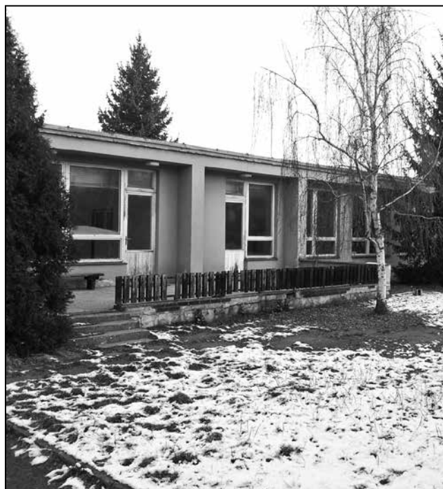
Současný stav budovy
